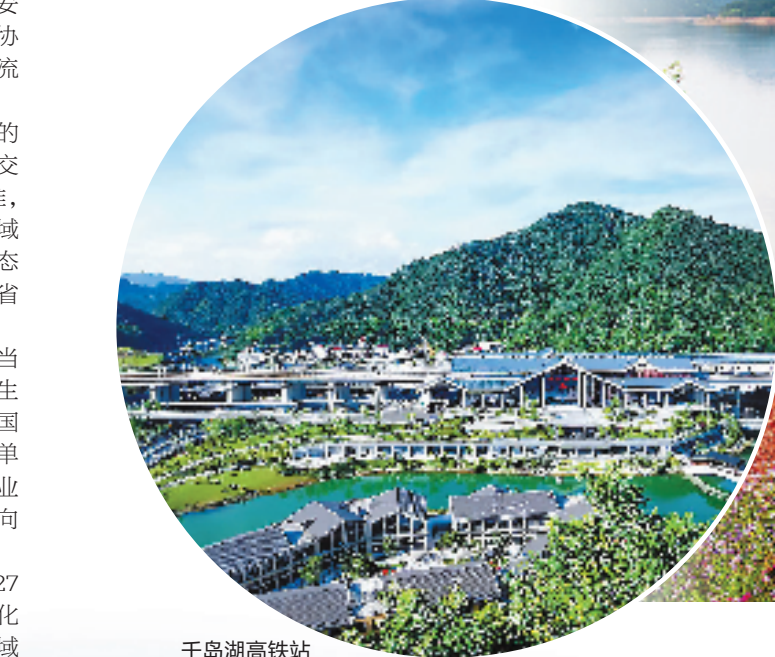
千岛湖高铁站
