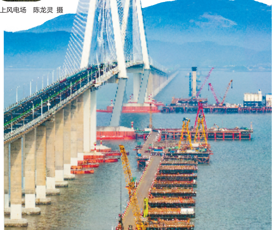
建设中的宁波市域铁路象山港跨海大桥 罗耀辉 摄
