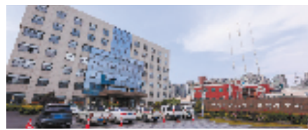
城厢街道社会治理综合中心
