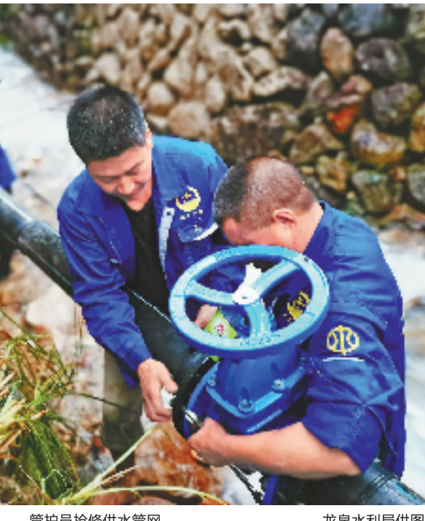
管护员抢修供水管网。龙泉水利局供图
