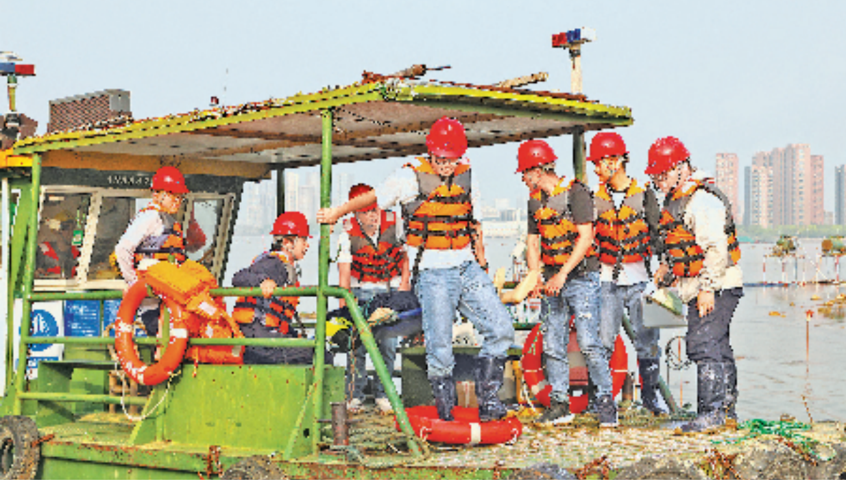
4月15日,浙江正式汛。当天,在杭州城西西南排九溪出水口枢纽段一期围堰施工现场,全工区7个单位、4支演练队伍共60余人参加防汛应急演练。
