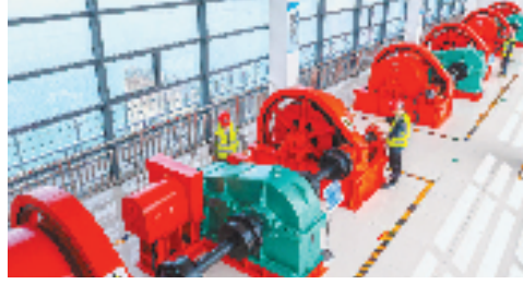
4月15日,在长兴县合溪水库,工作人员在启闭机房,对设备进行检修。
