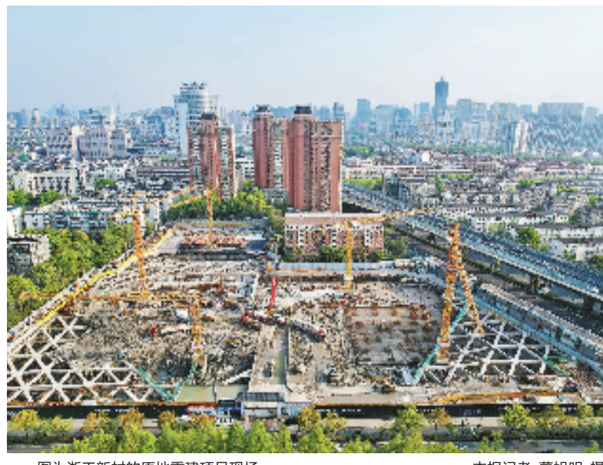
图为浙江新村的原地重建项目现场。
