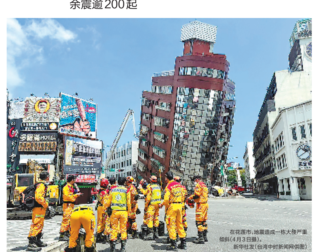
在花莲市,地震造成一栋大楼严重倾斜。(4月3日摄)。新华社发(台湾中时新闻网供图)
