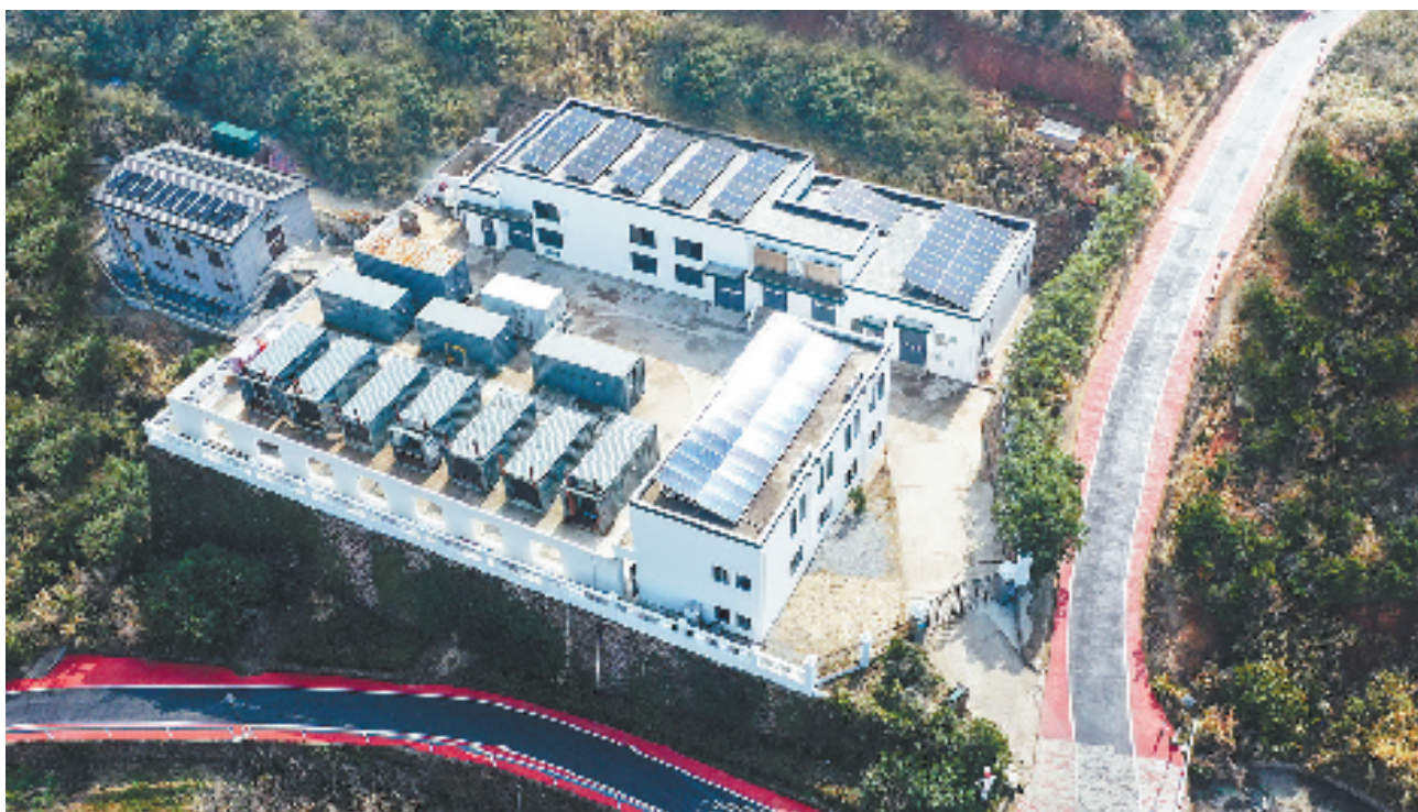
微电网屋顶光伏 张道历 摄
