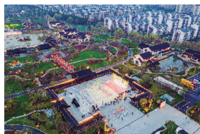
新塍镇蓬莱公园 嘉兴市秀洲区新塍镇供图
