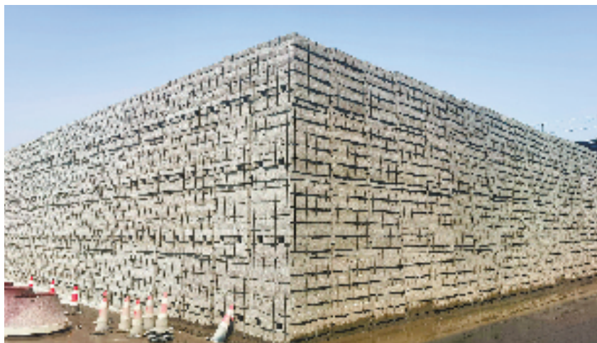
装修垃圾经过循环处理,制成混凝土砖块。
