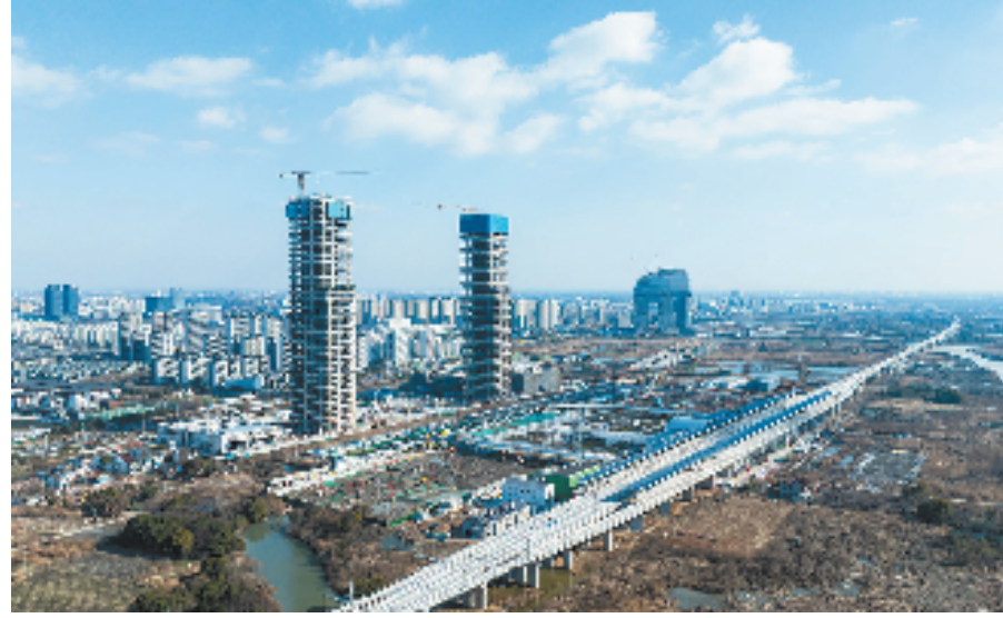
在南浔,一批批重点工程建设项目火热推进。 陈志斌 摄
