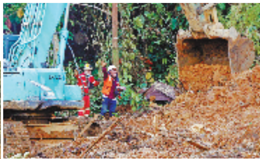
1月14日,搜救人员在山体滑坡事故现场工作。
