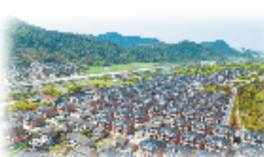
奉化区西坞街道实施农村住房改造，村民们搬入新居，实现了“山上绿色银行、山下别墅成行”的美好愿景。 樊建成 摄
