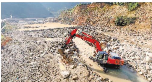
11月15日,杭州淳安县宋村乡桐溪流域综合治理工程工地上,施工人员趁着河道处于枯水期,加紧进行疏浚河道、加固护岸、修建堰坝等施工。
