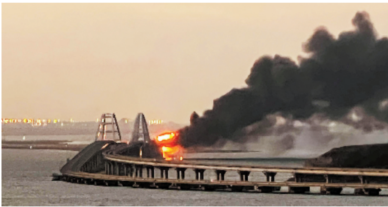
克里米亚大桥起火现场。
