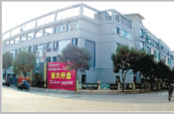
原嵊州市金帅旗领带服饰有限公司改造为城南农贸综合市场(改造后)
