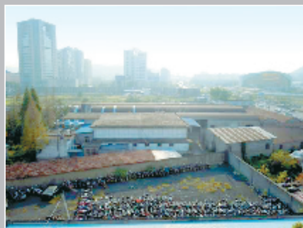
新昌县七星街道冷库地块违建拆除前
