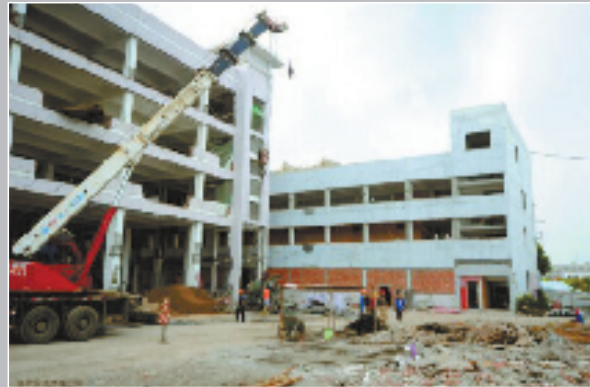
原嵊州市金帅旗领带服饰有限公司改造为城南农贸综合市场(改造前)
