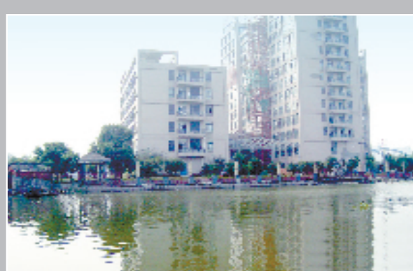
袍江赵墅违建船屋拆除后
