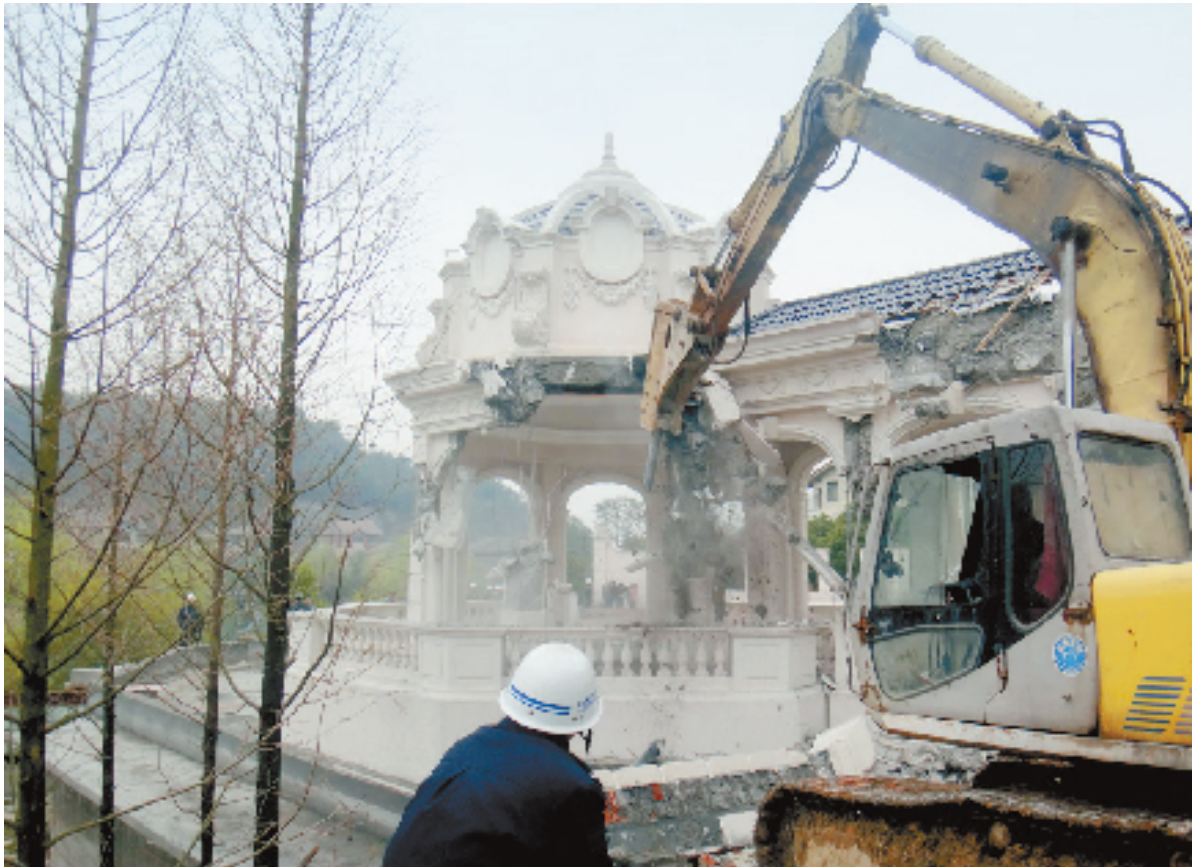
上虞梁湖镇天香华庭小区违法建筑被拆除
