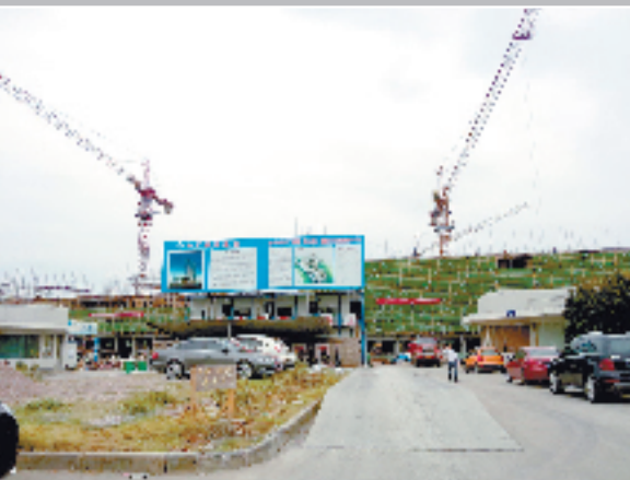
诸暨市陶朱街道违建拆除后变为1000多套住宅的安置小区、公园广场，计划在今年底封顶
