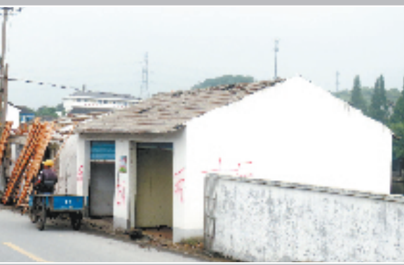
越城区凤凰村坡塘江段沿河违建拆除前
