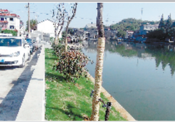
越城区凤凰村坡塘江段沿河违建拆除后
