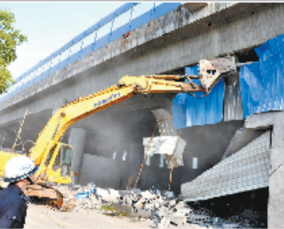
嵊州城南新区禹金高速违建拆除中
