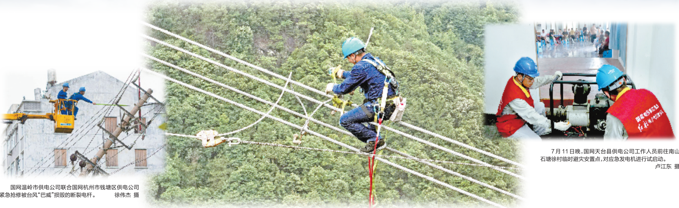
7月12日，国网台州供电公司输电运检中心组织开展500千伏浦潭线架空地线更换抢修作业。
