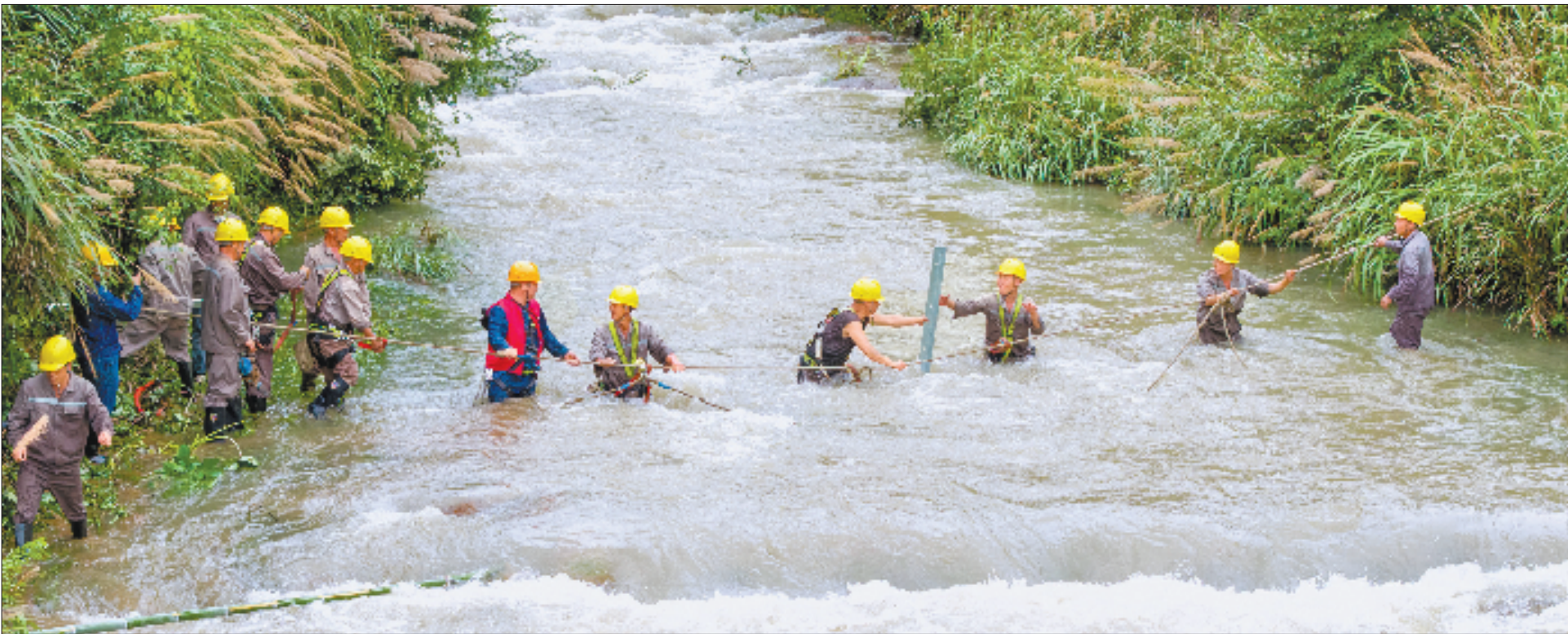
7月12日,受台风“巴威”影响,新昌县多处电力线路断线受损,部分区域供电中断。国网新昌县供电公司迅速组织力量抢修受损电网。上午10时,儒岙镇东山村大坑自然村报告电力线路断线。故障点位于石磁溪旁,河面宽约十余米,常规通行道路已被淹没,若绕行山路需一个半小时。为缩短停电时间,儒岙供电所抢修人员决定涉水通过。图为抢修人员系好保护绳,手拉绳索,在齐腰深的急流中跋涉过河。 通讯员 俞晓委 摄
