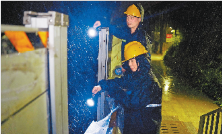
7月11日晚,在余姚市丈亭镇,工作人员沿姚江巡查,加固防洪挡板。
