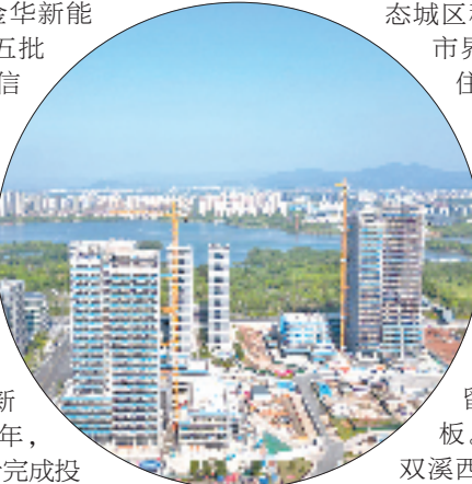
位于中央创新城（南区）的长三角科技创新产业园（金创绿谷一期）建设正酣。 宋洁梅 摄
