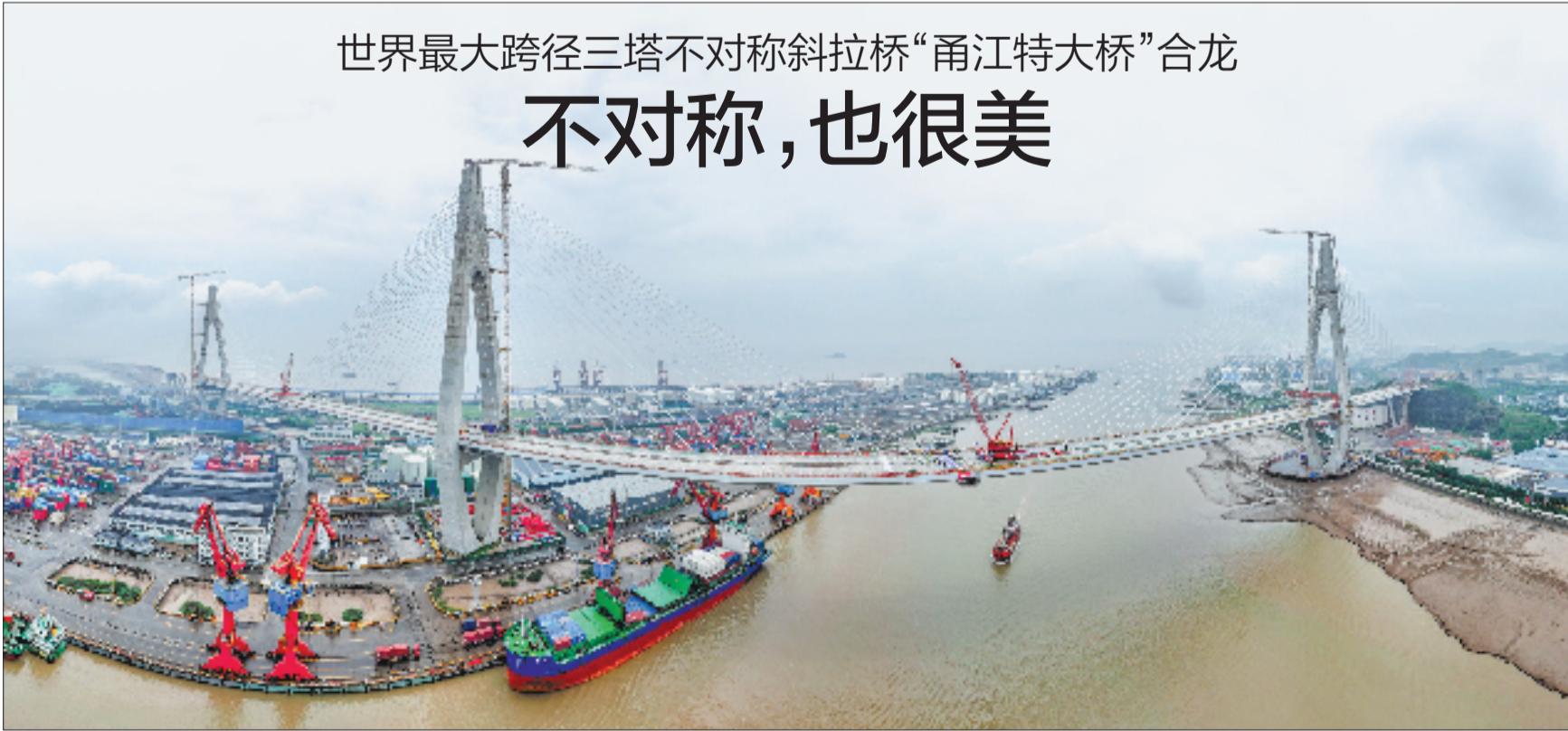
图为甬江特大桥合龙现场。
