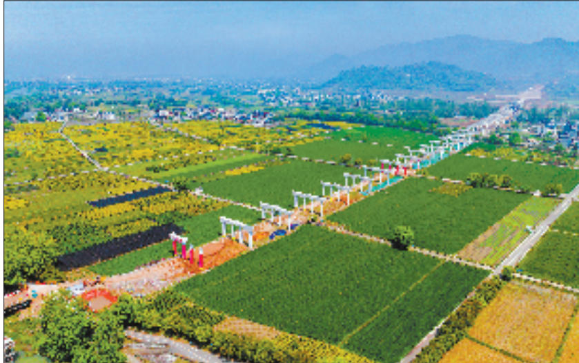
义龙庆高速丽水段松阴溪大桥施工现场
