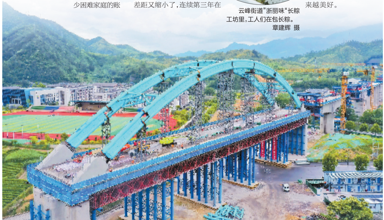
衢丽铁路遂昌段建设现场
