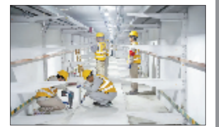
施工人员安装消防设施
