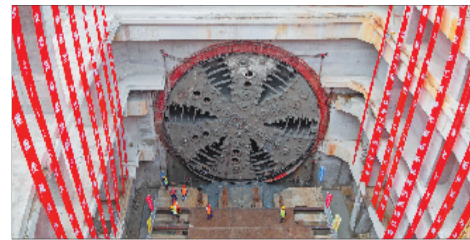
“和合号”盾构机破土而出,台州市解放路过江隧道东线盾构隧道贯通。 本报记者 叶剑锋 摄
