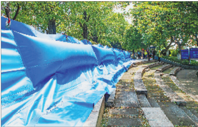
6月17日,金华市婺城区金华江岸边,抢险人员正在安装浮力式挡水子堤,进行城区堤防防汛应急演练。通讯员 胡肖飞 摄
