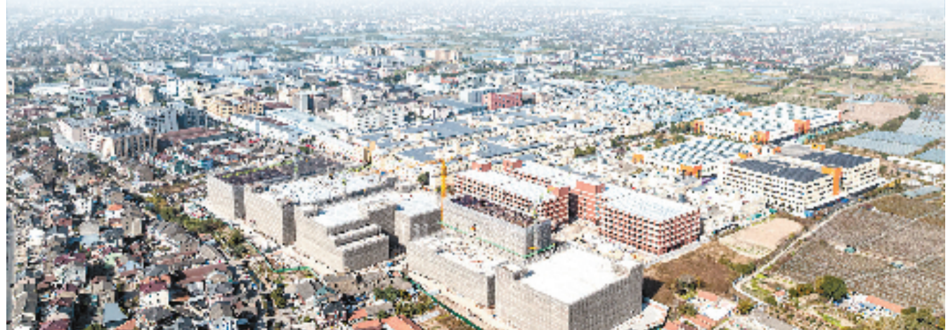
重大项目——慈工智创·桥头智谷产业园
