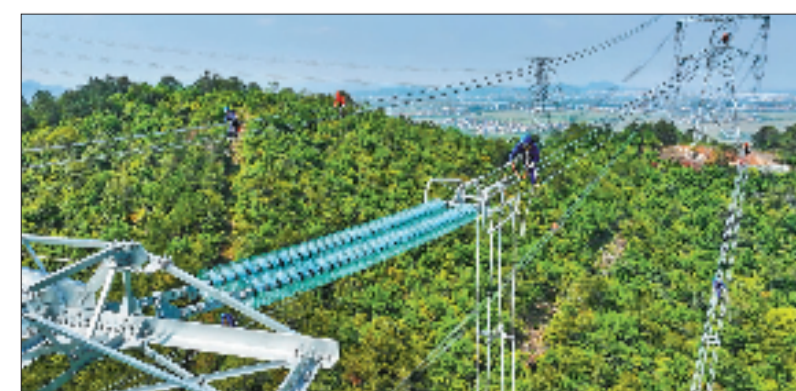
5月22日,甘浙特高压首条受端500千伏配套工程在宁波贯通。甘浙特高压工程全面建成后,预计每年可向浙江输送电量超360亿千瓦时。图为国网宁波供电公司员工在对配套工程线路进行最后的走线验收。 本报记者 李华 通讯员 盛家豪 摄
