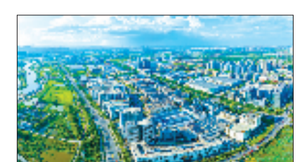
余杭经济开发区 图片由余杭经济开发区提供
