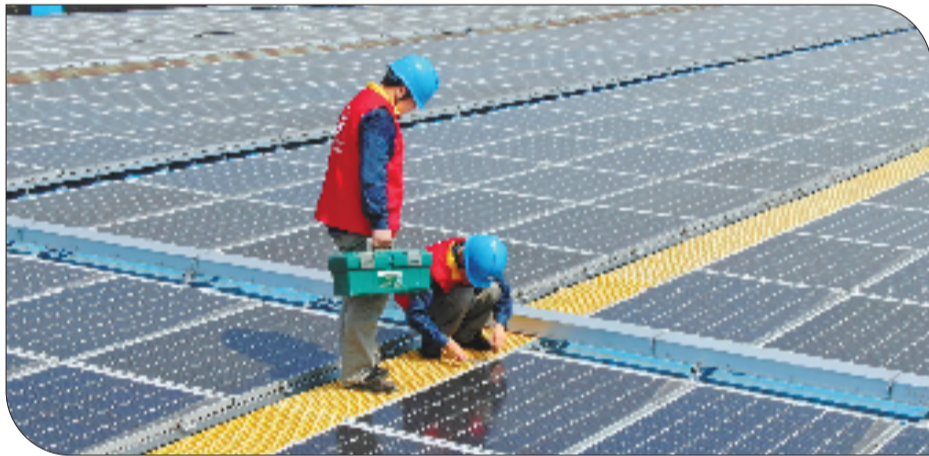
国网衢州供电公司工作人员在浙江明旺乳业有限公司厂区屋顶检查光伏板,帮助企业推进碳账户节能改造。
