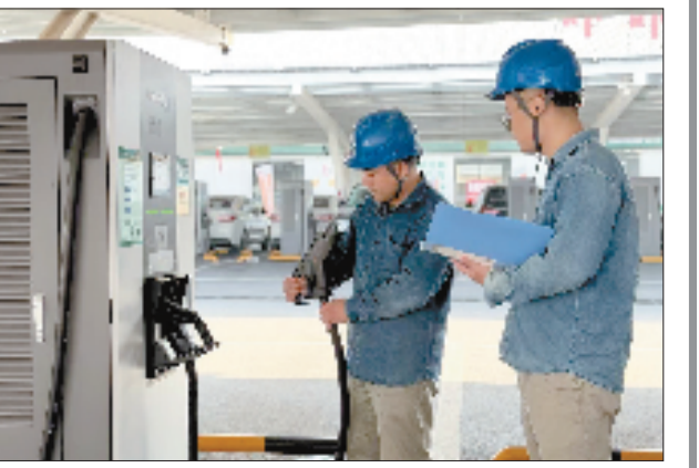
光明集团运维人员节前巡检
