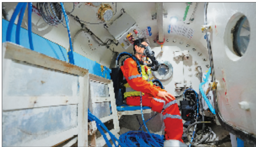
图为5月8日，作业人员佩戴专用混合气体呼吸器进行试压，准备换刀作业。 本报记者 胡元勇 周旭辉 沈晏 通讯员 张玺 摄 （相关报道详见第二版）
