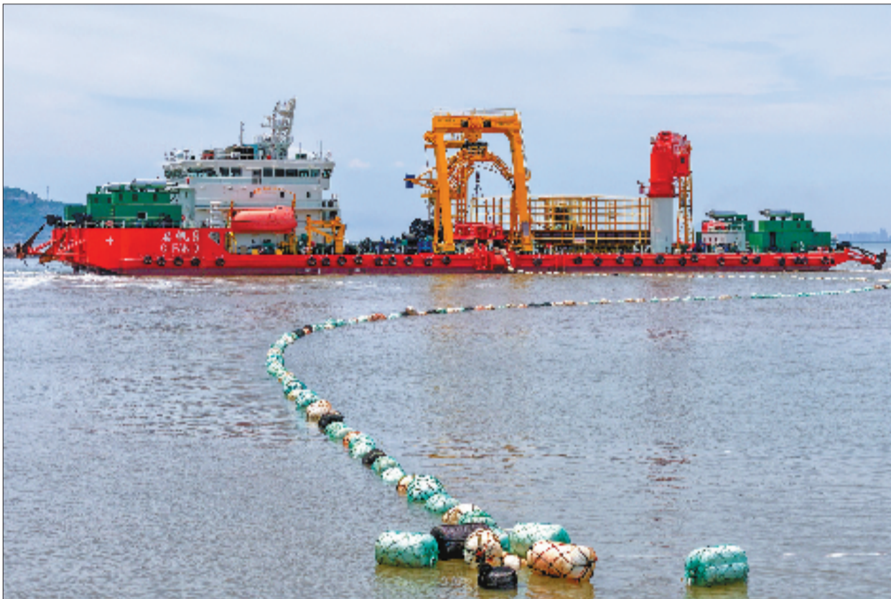
图为海缆敷设施工现场。
