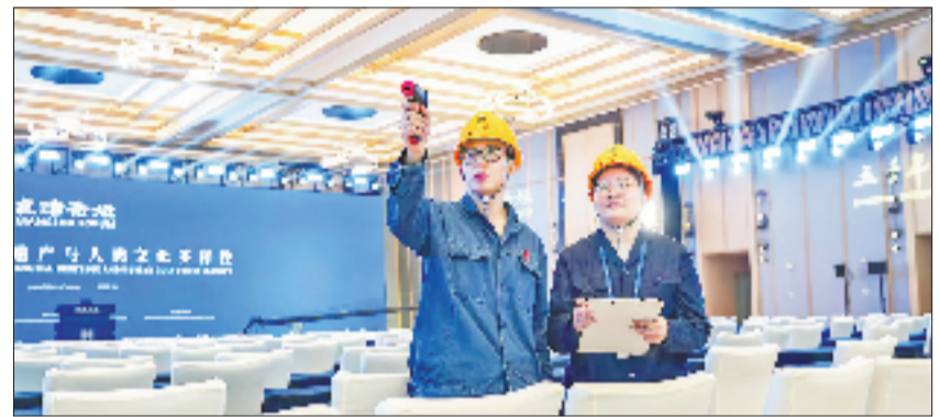
第三届“良渚论坛”期间，国网杭州市余杭区供电公司董丽澜(右)在主场馆开展负荷测试、设备测温等工作，高标准保障大会平稳用电。 陈佳怡 摄
