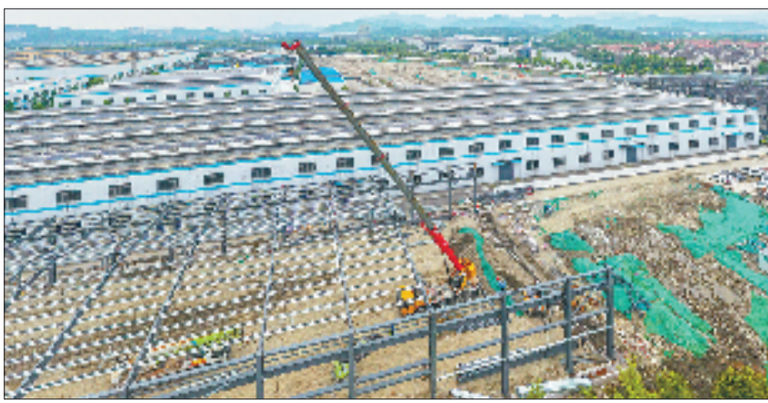
索密克智能化车间项目施工现场
