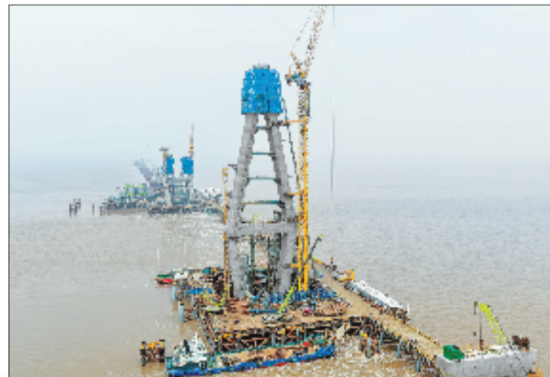
近日,通苏嘉甬杭州湾跨海铁路桥施工现场一派繁忙。通讯员 姚峰 张滔 王昊 摄
