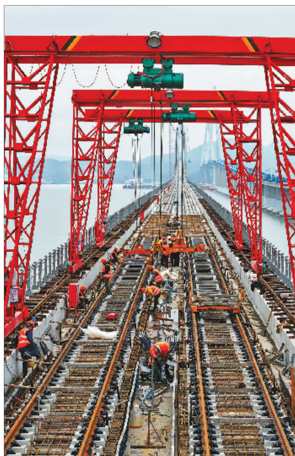
连日来,宁波市域铁路象山线轨道铺设正紧锣密鼓进行中。 本报记者 贺元凯 通讯员 杨忠华 摄
