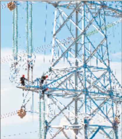
三门核电二期500千伏送出工程正在加紧放线施工。
