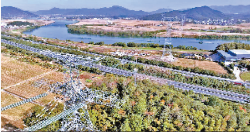
甘浙特高压工程浙江段线路架设跨越曹娥江
