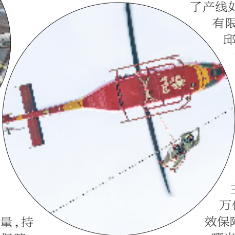
国网温州供电公司应用直升机吊索法,对220千伏瓯湖线开展光缆抢修。
