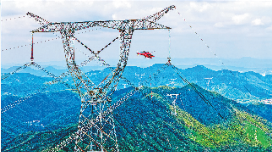
10月23日,在湖州市安吉县递铺镇,国网湖州供电公司联合国网电力空间技术有限公司对特高压1000千伏安兰线开展直升机带电检修。
