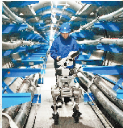
9月23日,国网绍兴供电公司工作人员正在运用巡检机器人对地下电缆隧道进行巡视,排查安全隐患。
