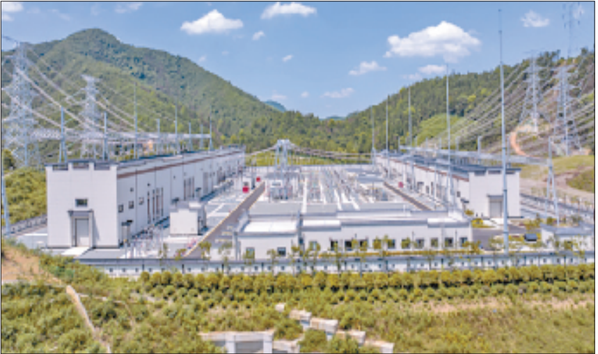
杭州建德500千伏变电站创造性地将变电站“嵌入”废弃水库,实现变电站工业建筑与自然景观的有机结合。
