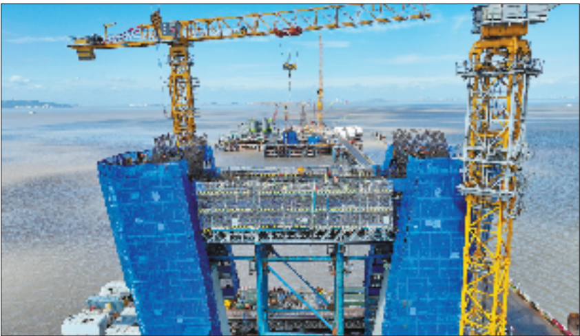
杭州湾跨海铁路桥南航道桥主塔施工现场。
