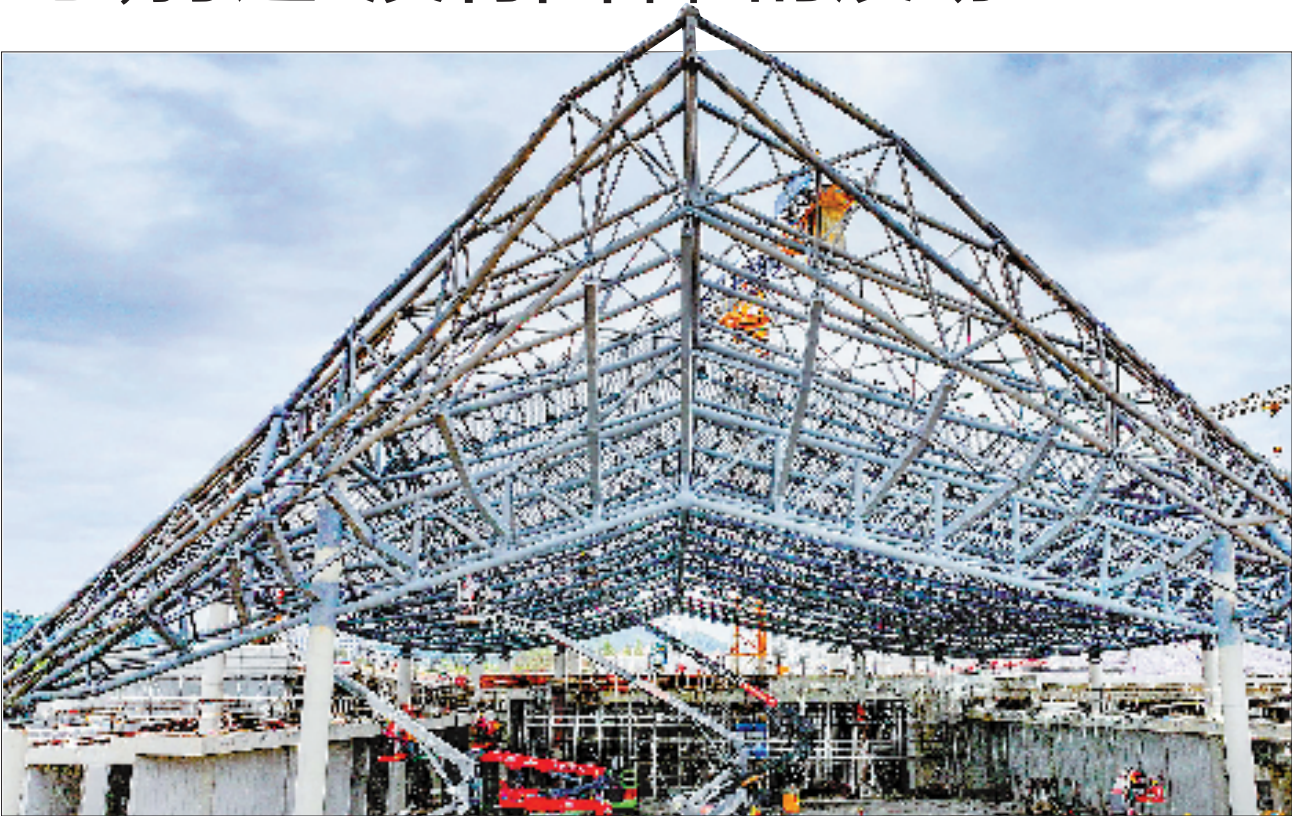
温州园博园项目山水中国馆建设现场,工人正在进行金属屋面安装。
