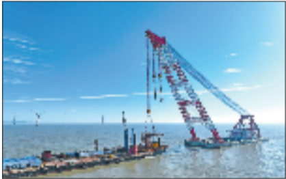
华电玉环南区海上风电建设，起重船正将风电基础构件精准吊装至预定海域，展现海上风电建设的核心作业场景，镜头定格了工程机械与海洋风能的交响，记录向“双碳”目标迈进的坚实步伐。
