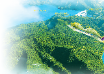
衢州乌溪江混合式抽水蓄能电站效果图
