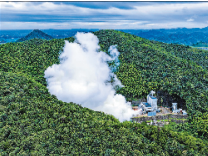
湖州蓝箭航天热态试验中心,正在测试一台朱雀二号发动机,群山环抱的矿坑成为天然的“隔音屏障”。
