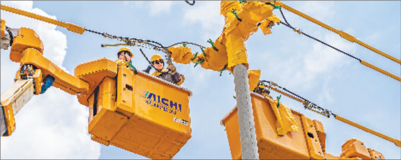
7月16日，柯城区华墅乡，国网衢州供电公司带电作业班员工身着绝缘服完成线路改造任务。
