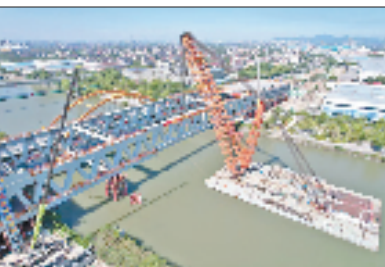
余杭区东西大道运河大桥改造工程中跨主桁合龙
