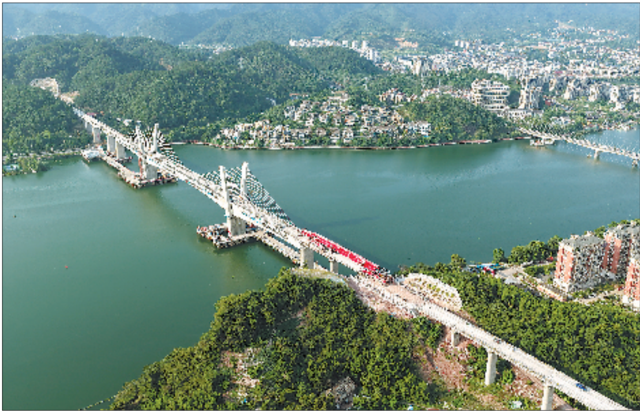
图为架设金建高铁最后一根箱梁。
