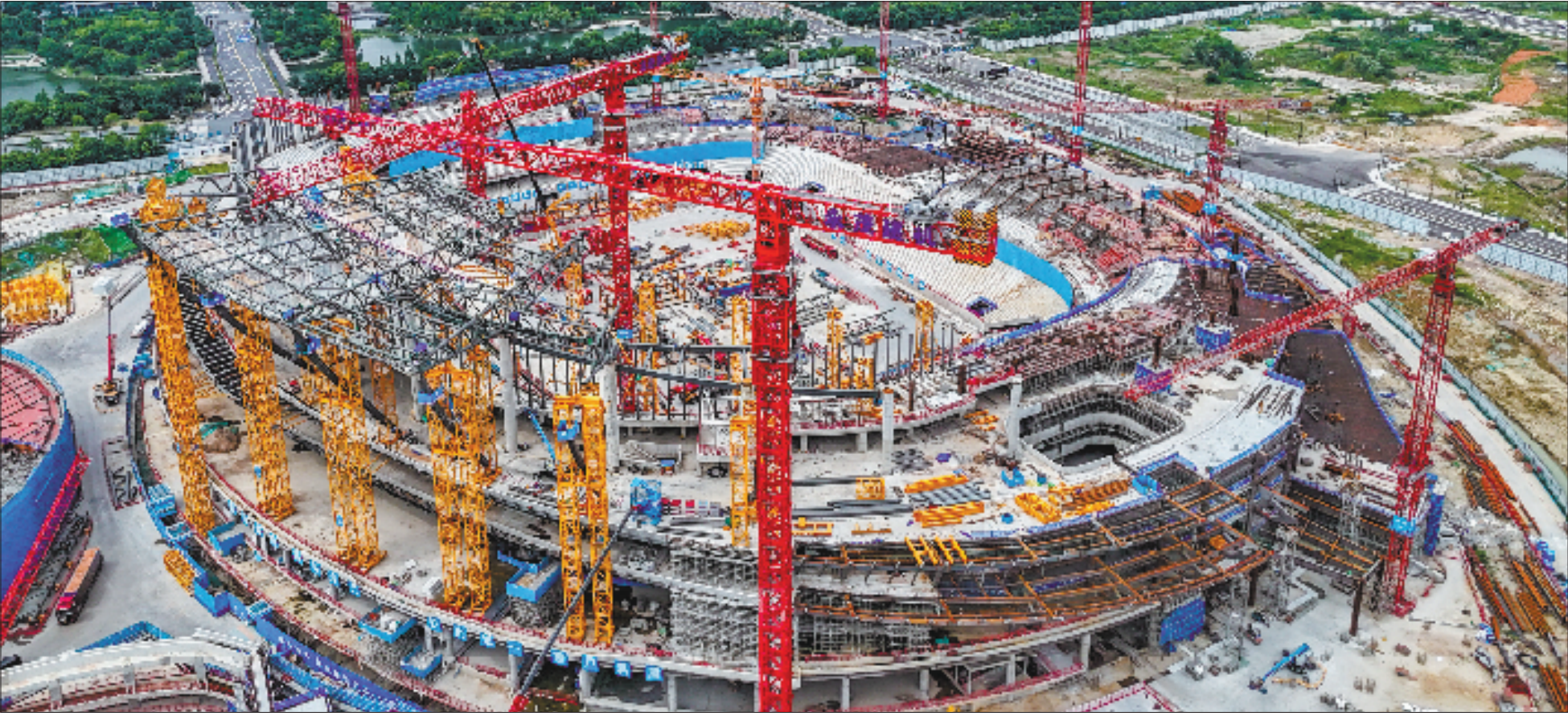
7月16日,杭州余杭国际体育中心专业足球场项目建设现场,大型吊机正在进行钢结构屋盖桁架吊装作业。目前,这座浙江首个6万座专业足球场已进入大跨度空间结构施工阶段,足球场穹顶结构正逐步成型,为后续索膜结构、幕墙工程等施工奠定基础。作为省“千项万亿”重大项目,余杭国际体育中心总建筑面积53.4万平方米,包含专业足球场、综合体育馆和游泳馆。 本报记者 董旭明 摄
